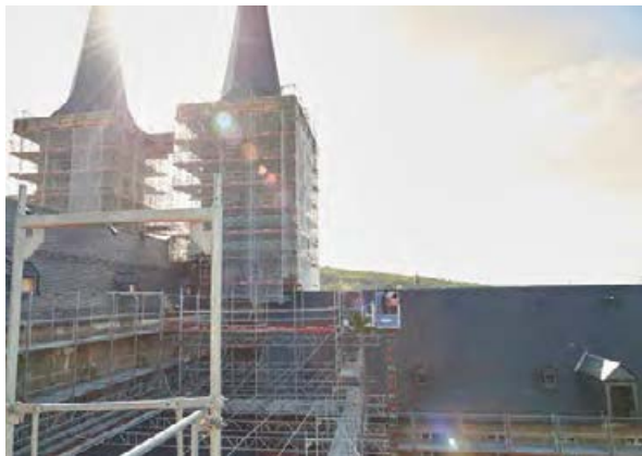
Richtfest am Michaelsberg in schwindelnder Höhe.
