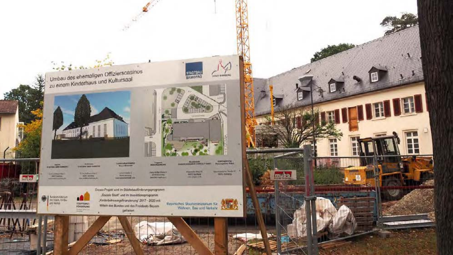
Das ehemalige Offizierscasino wird zum Kinderhaus umgebaut. Die Fertigstellung ist bis Anfang 2021 vorgesehen.
